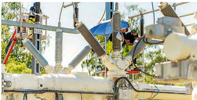
Putzen, wo sonst 110.000 Volt transportiert werden. Foto: Stuttgart Netze
