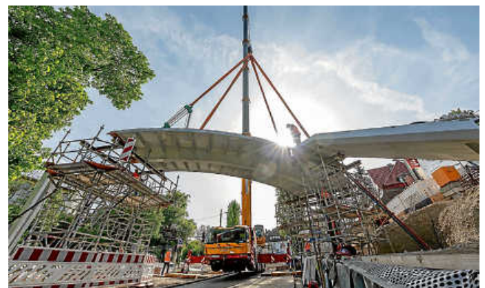
Ein Teilstück der Brücke wird eingesetzt.
