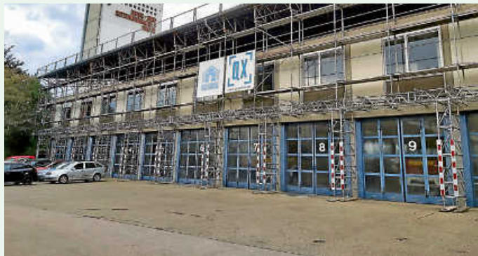
Das Feuerwehrgebäude wird noch für die Ausbildung genutzt. Foto: Stotz
