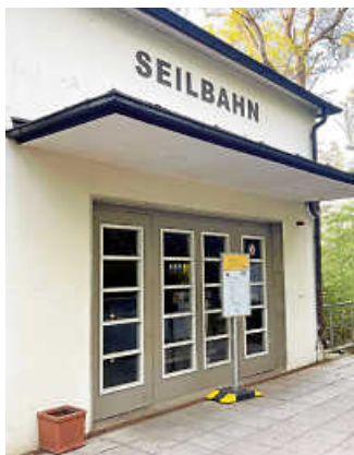
Die Seilbahn steht.
