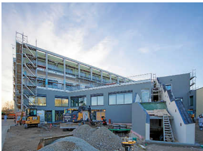
Der Neubau in der Tränke wächst.
