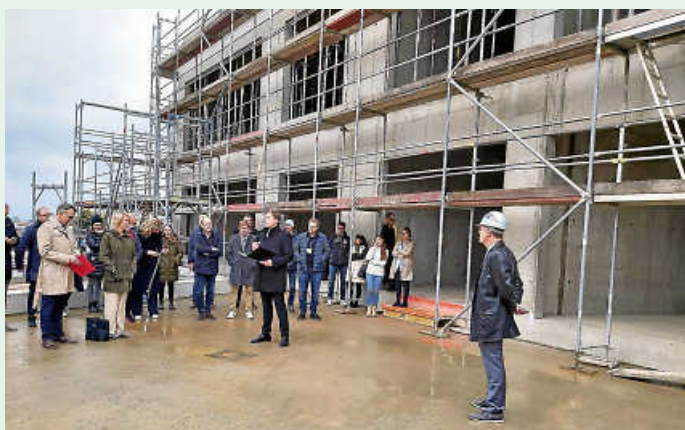
Im vergangenen April wurde Richtfest gefeiert.
