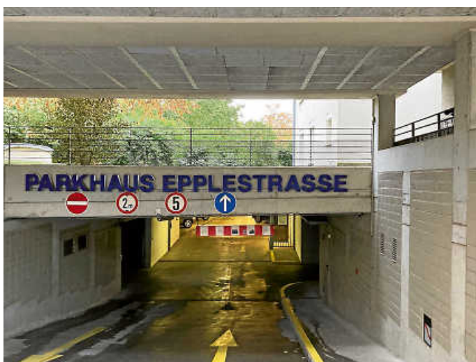
Die Tiefgarage wird auf Erweiterbarkeit geprüft.
