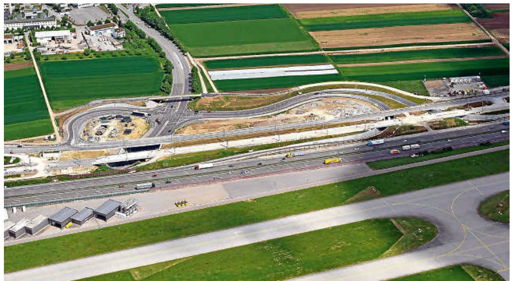
Die A8-Anschlussstelle Plieningen mit Ein- und Auffahrampen
