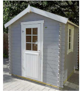
Die Hütte steht.
