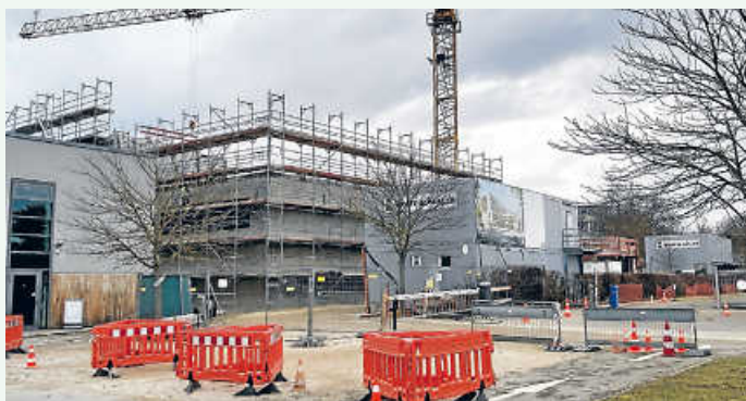
Das neue Schulgebäude nimmt langsam Gestalt an.
