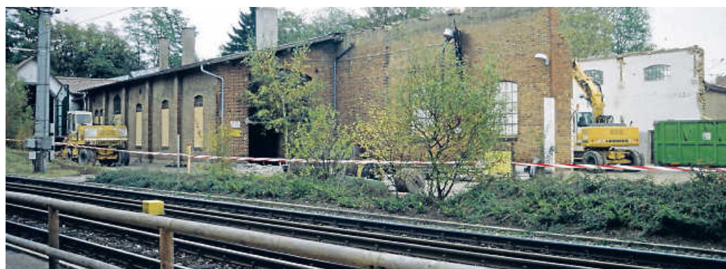
1997 wurde die alte Wagenhalle zwischen den Gleisen abgebrochen.
