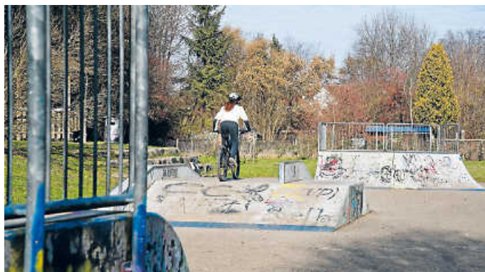
Die Skateranlage beim Wilhelms-Gymnasium soll saniert werden. Fotos: Kaier
