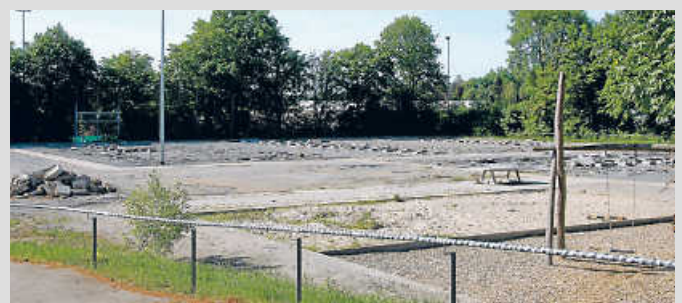
Auf der Waldau werden wieder Wohncontainer aufgestellt. Foto: pb
