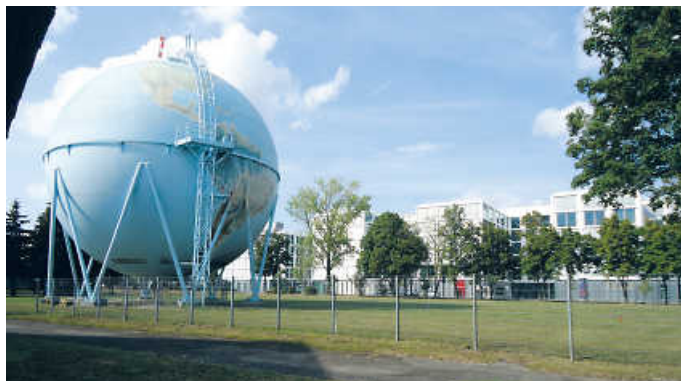
Noch bessere Stromversorgung für den Synergiepark.
