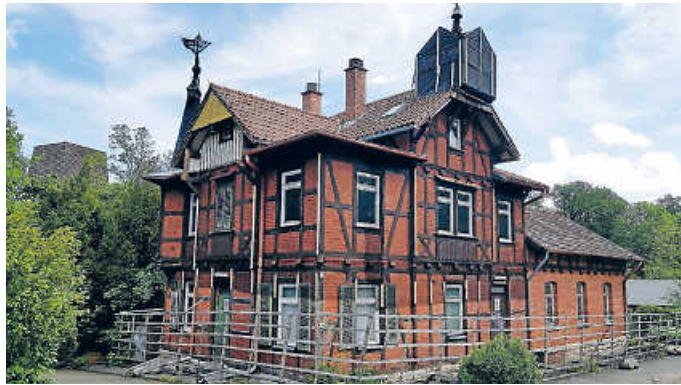
Das Garnisonsschützenhaus soll saniert werden.
