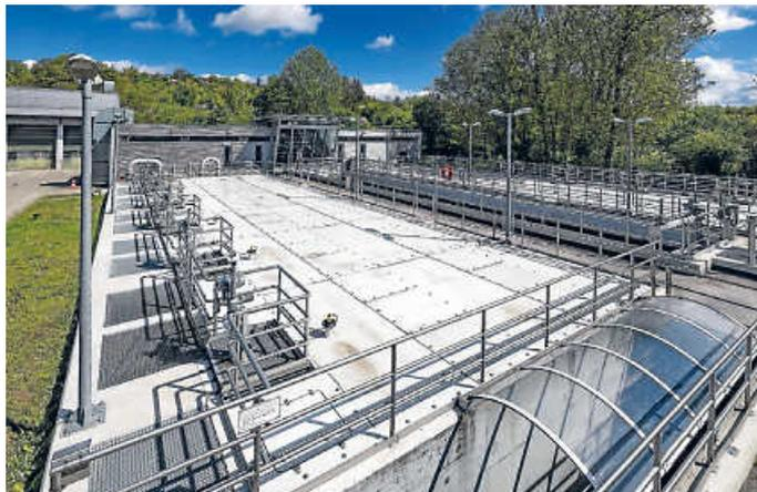
Die sanierte Sandfilteranlage im Klärwerk Plieningen. Foto: LHS
