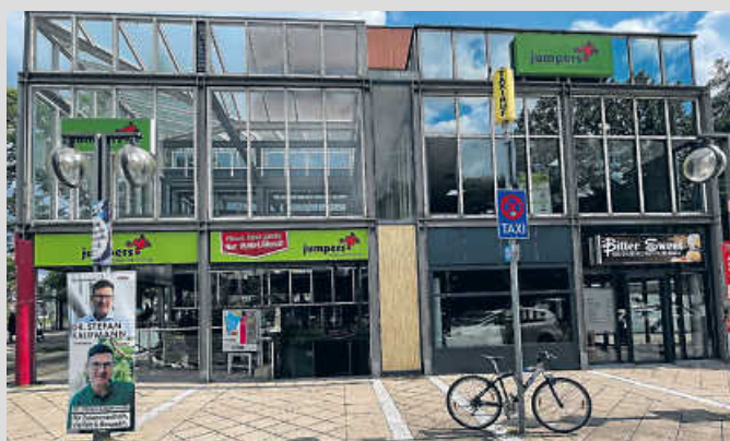
Berolinahaus am Altplatz – zentraler Aldi-Standort.
