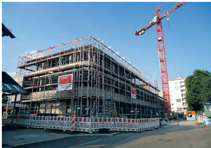
Baufortschritt: Der Rohbau bis zum ersten Geschoss steht. Foto: sm
