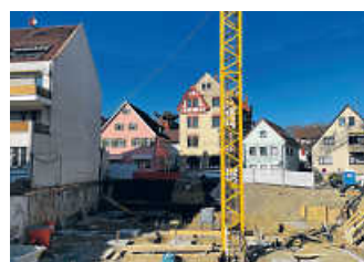
Baustelle Löwenstraße. Foto: fr
