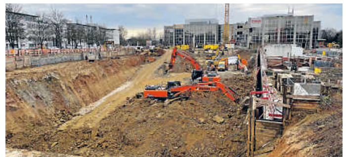
Großbaustelle an der Löffelstraße 34 bis 38.
