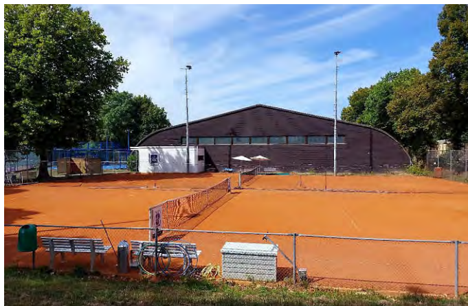
Die alte Halle ist marode und wird abgerissen.
