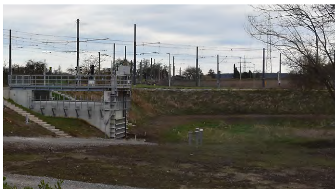
Das neue Regenüberlaufbecken am Sindelbach ist fertig. Foto: Kuhn
