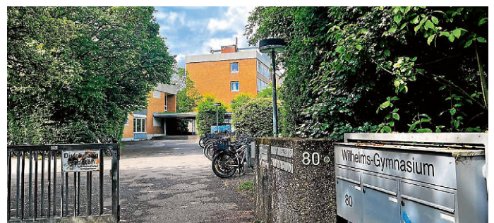
Das Wilhelms-Gymnasium wird saniert.
