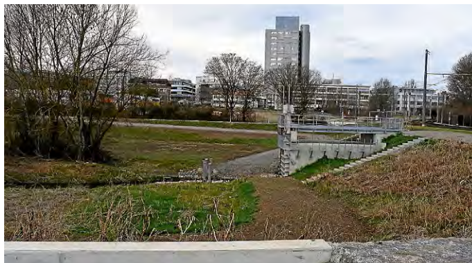
Das Becken hat ein Stauvolumen von 25.700 Kubikmetern.
