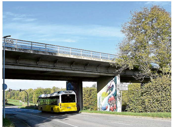
Körschtalbrücke an der B 27
