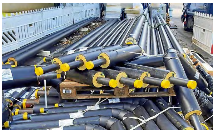
Für Wärmenetze werden solche Rohre verlegt.
